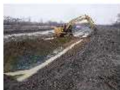
河道掘削 (石狩川水系、北海道開発局)
